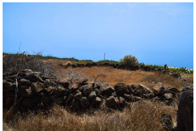
Südseite Blick nach Südwesten
