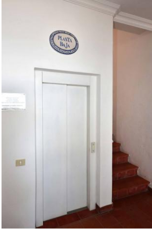
Treppenhaus mit Fahrstuhl
