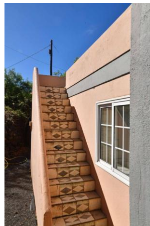
Treppe zur Dachterrasse 2 mit historischen Fliesen
