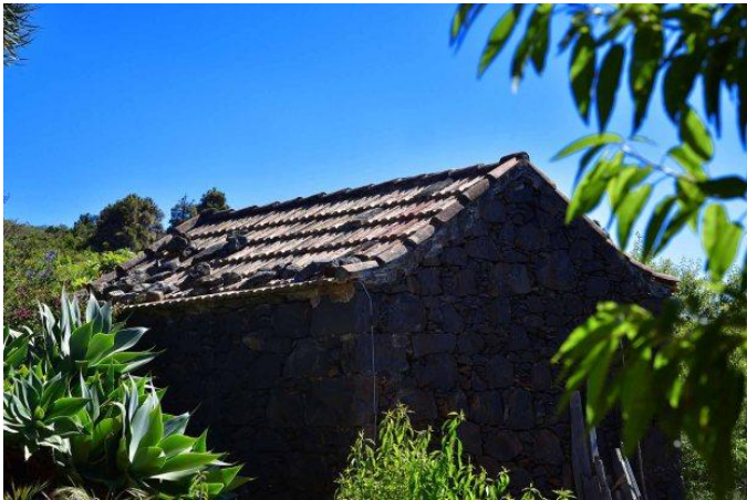
Gästehaus OG, Ansicht von Norden
