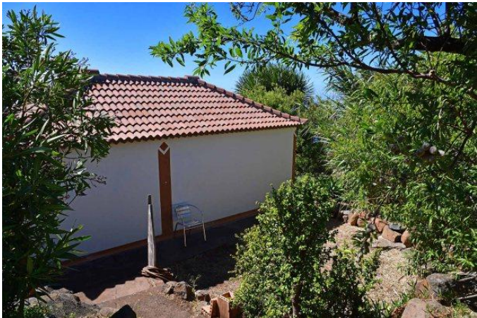
Haupthaus Ansicht von Norden
