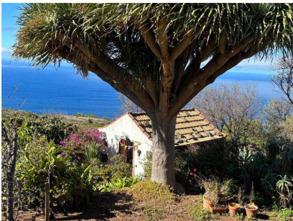
Gästehaus, Ansicht von Südosten
