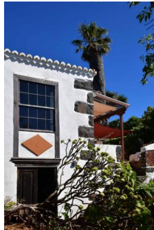
Haupthaus, Ansicht von Nordwesten
