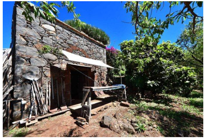
Gästehaus, Ansicht von Nordwesten
