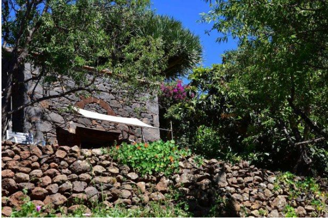
Gästehaus, Ansicht von Nordwesten
