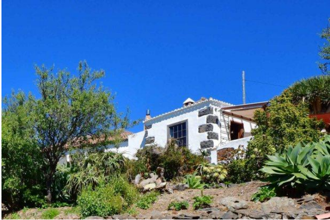
Haupthaus Ansicht von Westnordwest
