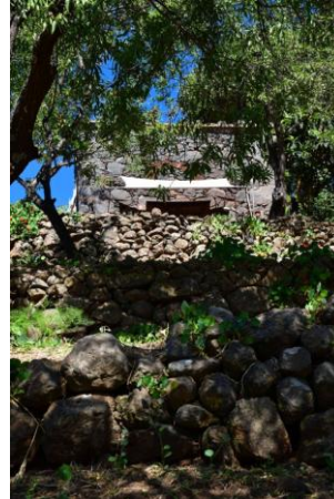
Gästehaus, Ansicht von Nordwesten
