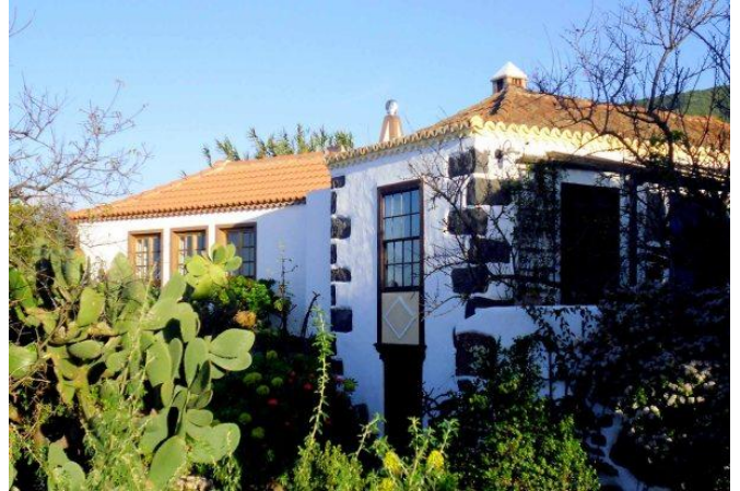
Haupthaus Ansicht von Westen
