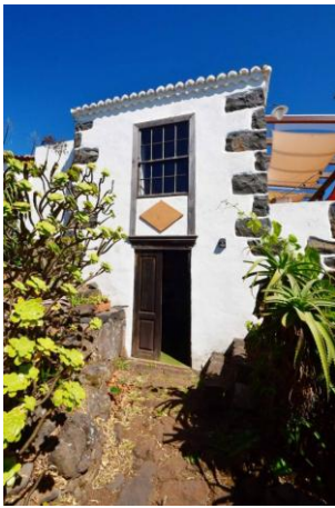
Haupthaus Ansicht von Nordwesten
