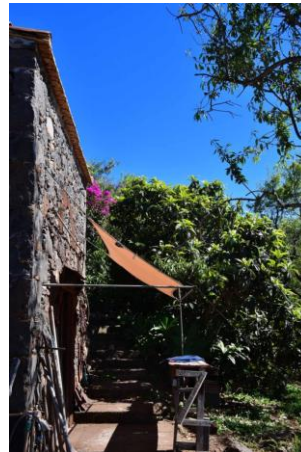
Gästehaus EG, Ansicht von Norden
