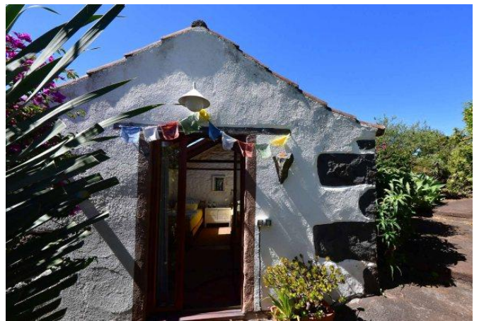
Gästehaus OG, Ansicht von Süden
