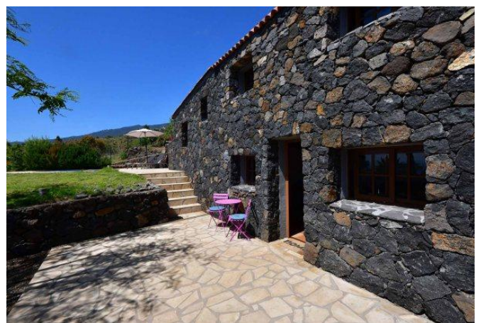
Ansicht von Südwesten, Ausgang zum Pool
