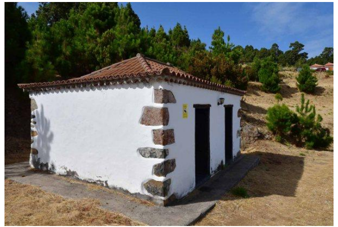
Altkanarisches Wohnhaus von Osten
