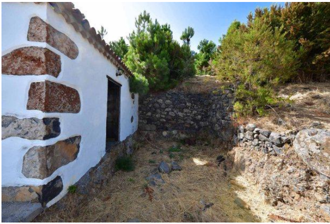
Vorbereiteter Platz für Erweiterung um Küche und Badezimmer
