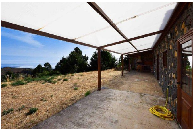
Unteres Wohnhaus mit großer, überdachter Terrasse
