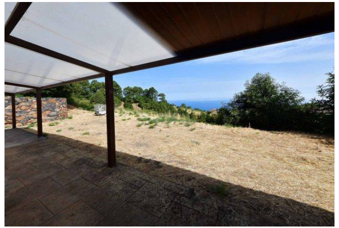
Unteres Wohnhaus mit großer, überdachter Terrasse
