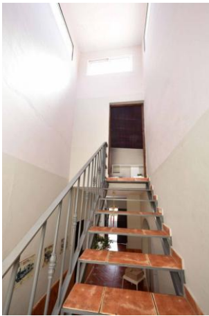
WG Innentreppe zum OG
