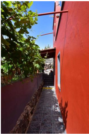
EG Durchgang zum Pool und Aussentreppe OG
