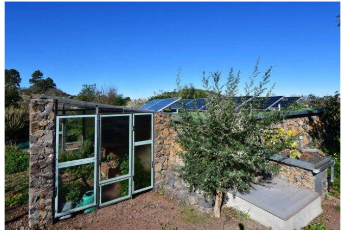
Wassertank mit PV-Anlage und Gewächshaus
