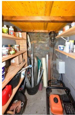
Technikraum am Haupthaus
