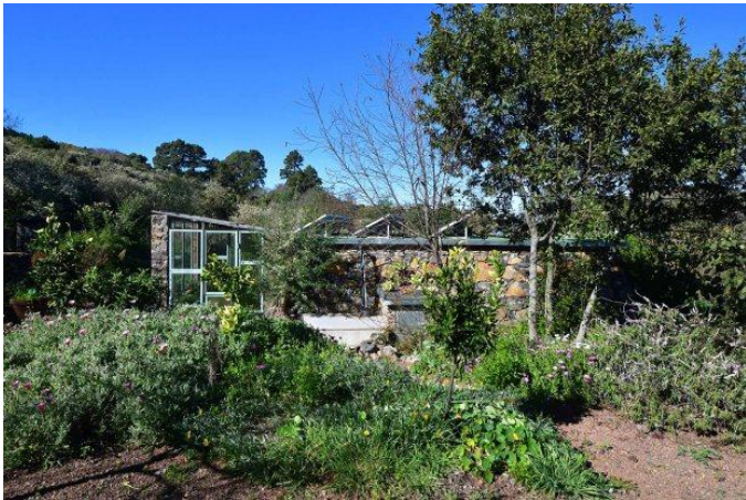
Wassertank mit PV-Anlage und Gewächshaus
