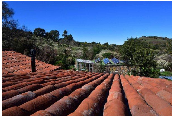
Sehr schön mit historischen Ziegeln sanierte Dächer
