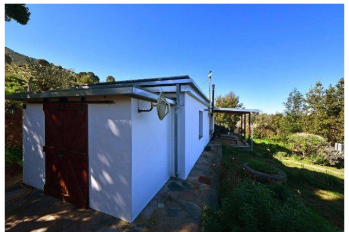
Technikraum am Haupthaus
