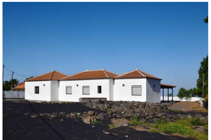
Ansicht von Nordosten
