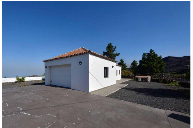
Ansicht von Südosten, Garage
