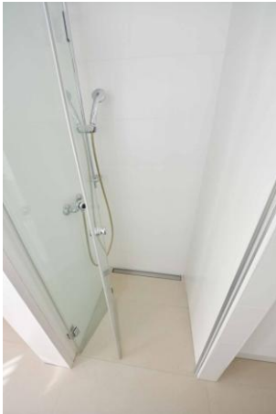
Badezimmer 2, bodengleiche Dusche
