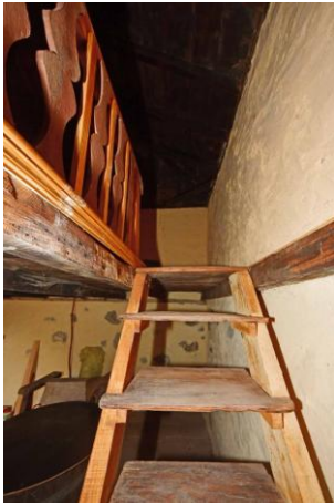
Halbuntergeschoss Aufgang Altbau
