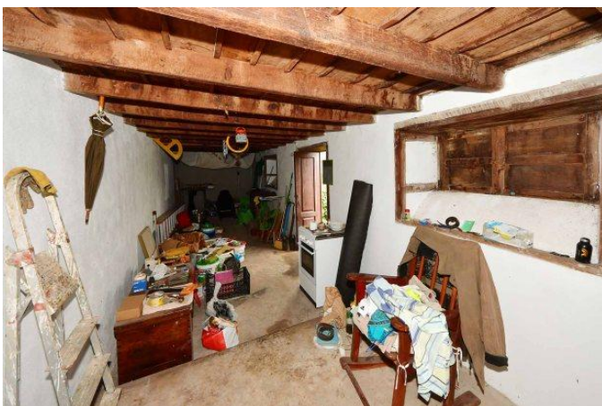
Halbuntergeschoss Neuerer Bau Lagerraum
