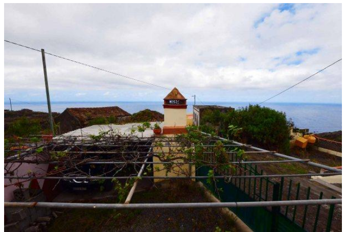
Aussicht Halbobergeschoss Neuerer Bau / Garage
