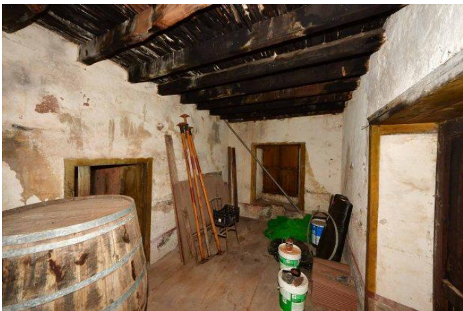
Halbuntergeschoss Altbau Küche
