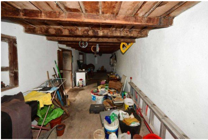
Halbuntergeschoss Neuerer Bau Lagerraum
