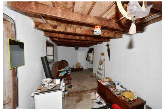
Halbuntergeschoss Neuerer Bau Lagerraum
