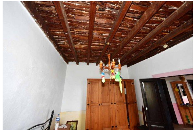
Halbobergeschoss Neuerer Bau Schlafzimmer 1
