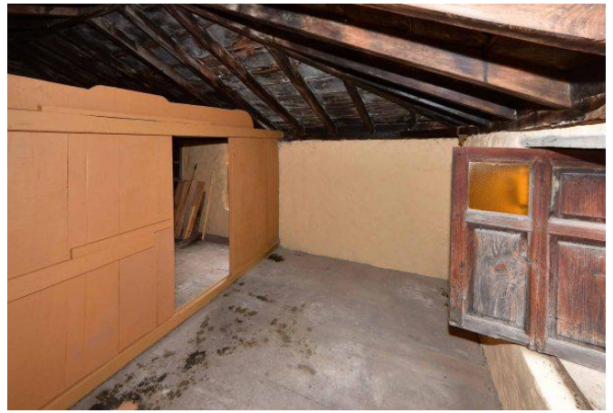
Halbobergeschoss Altbau Schlafzimmer 5
