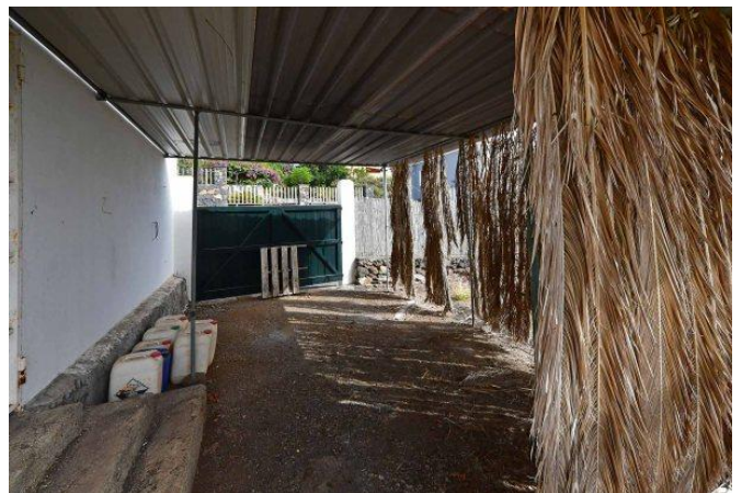
Carport an Südseite neben Hauptgarage
