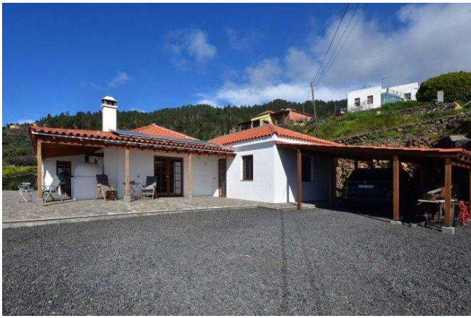
Ansicht von Südwesten, Carport
