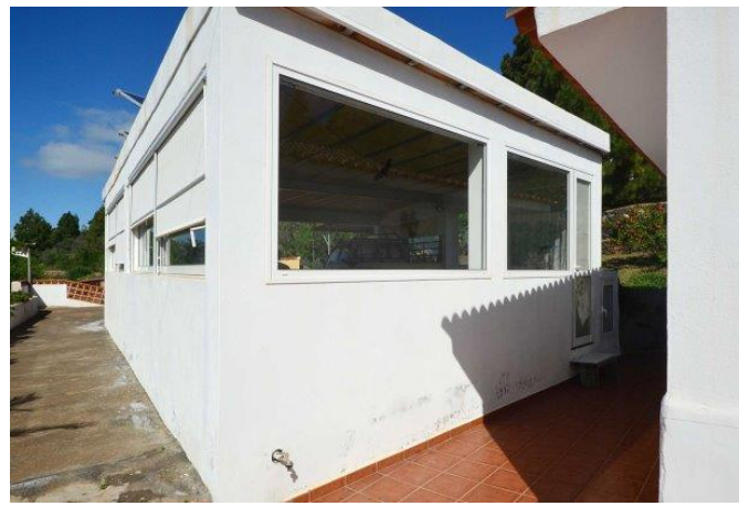
Garage mit Außenbeschattung
