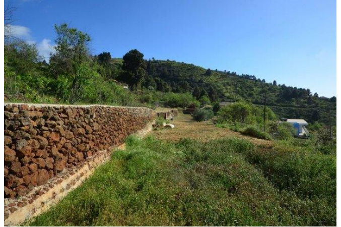
Freifläche für eigene Gartenträume
