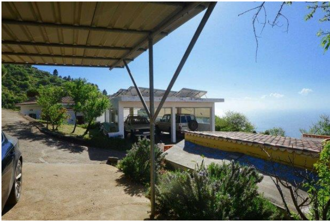
Carport, Garage, Werkstatt
