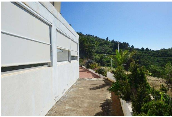
Garage mit Außenbeschattung
